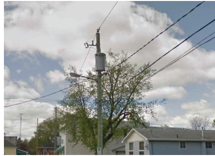
OVERHEAD HYDRO TRANSFORMER SCALE: N.T.S
